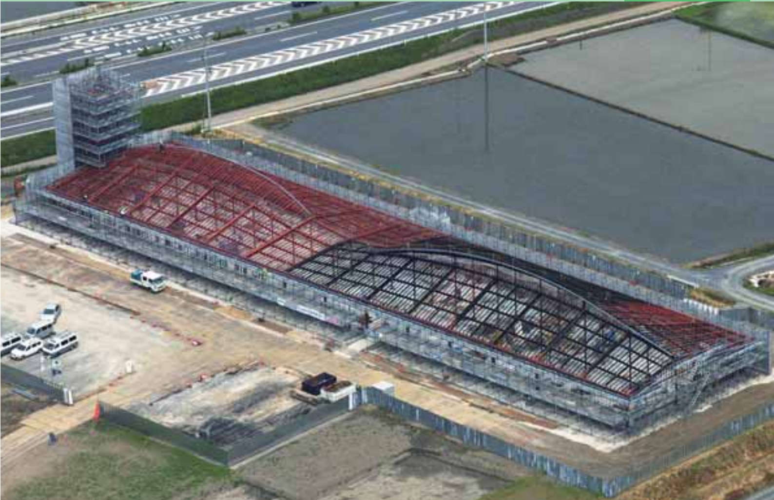
建設中の道の駅の航空写真
