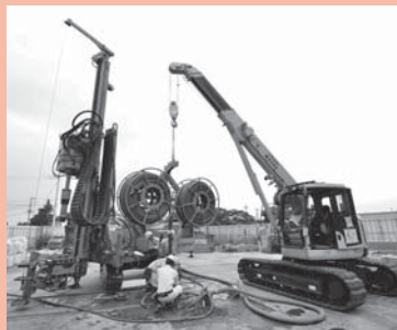
熱交換器設置工事の様子
