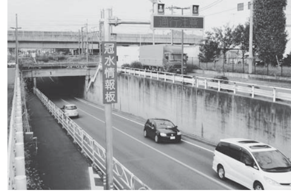
設置された道路情報提供施設
