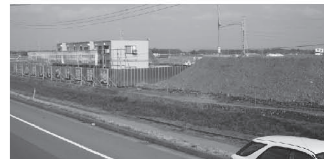
整備が進む道の駅（薬師寺地区内）
