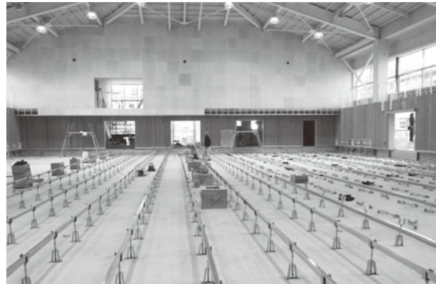
小学校屋内運動場改修工事
