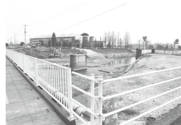
市道1-5号線整備（東田橋）
