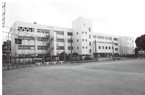
国分寺中学校校舎改修事業
