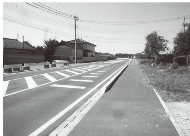
市道2-3号線整備事業(下長田地内)
