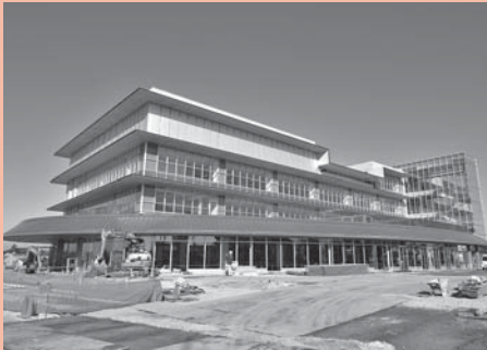
国道4号から見た新庁舎（1月13日撮影）
