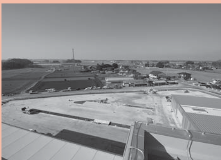
西側駐車場の様子（1月13日撮影）
