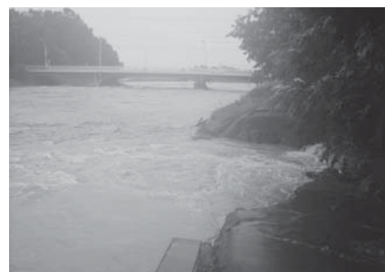
越流により削られた堤防
