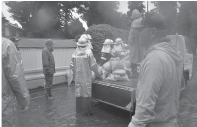
箕輪地区にて越流する堤防に土嚢を積みむ
