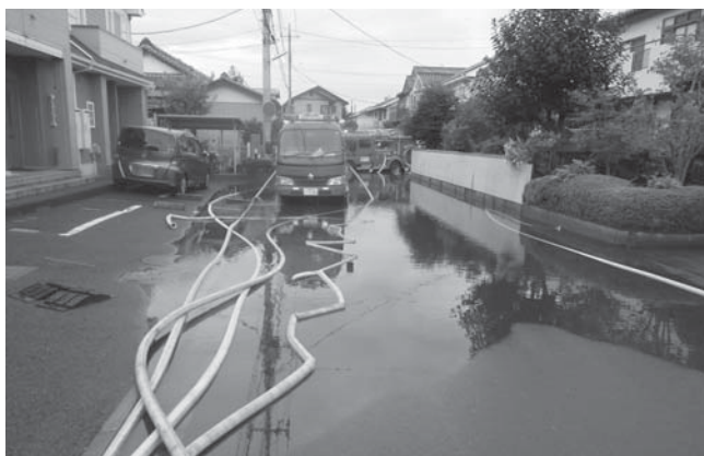
緑地区にてポンプ車7台で排水作業
