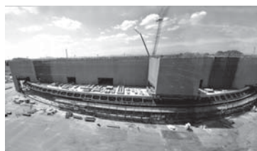
工事現場の様子
