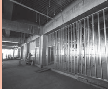
内装工事の様子
