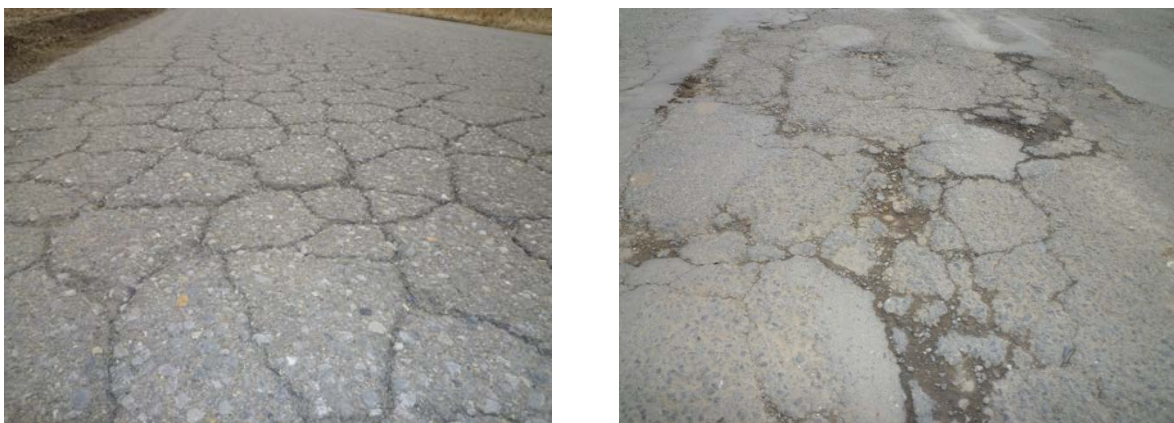
図 3-7 道路舗装の老朽化の状況（ひび割れ率別の延長割合）
