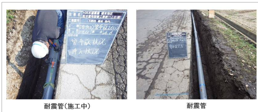
図 3-11 耐震性向上の施工（都市基盤施設の例）
