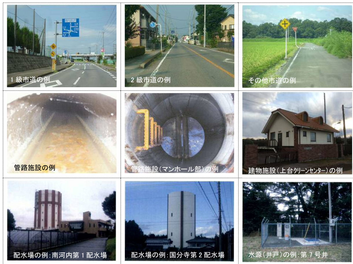
図 3-2 下野市が管理する都市基盤施設（インフラ）の例
