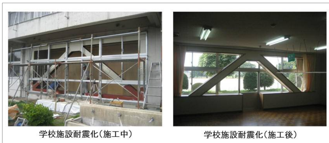
図 3-10 耐震性向上の施工（公共施設の例）
