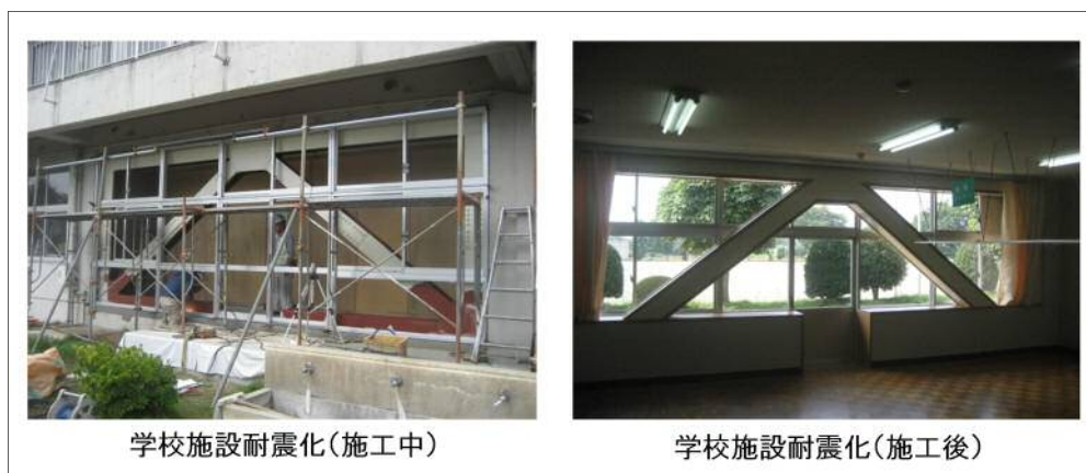
図 3-10 耐震性向上の施工（公共施設の例）
