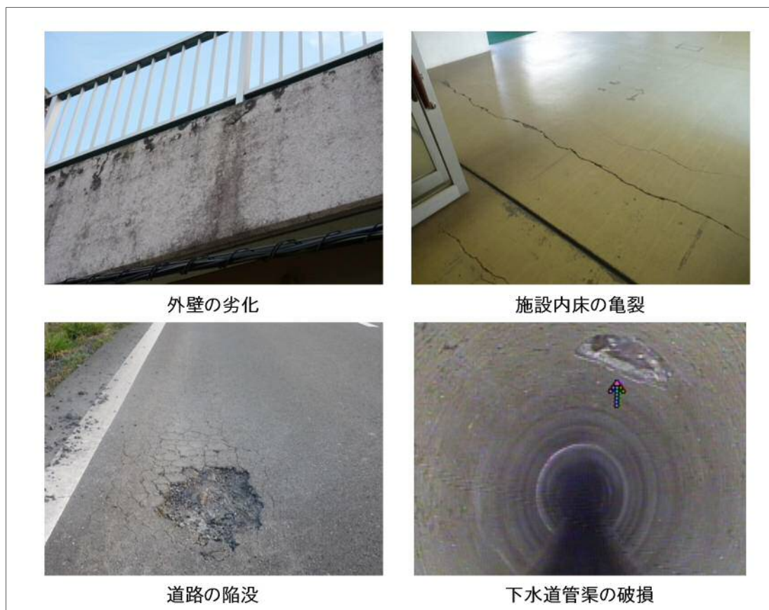
図 3-9 安全確保を要する現場の例
