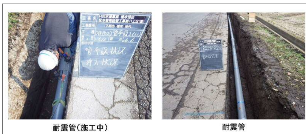
図 2-11 耐震性向上の施工（都市基盤施設の例）
