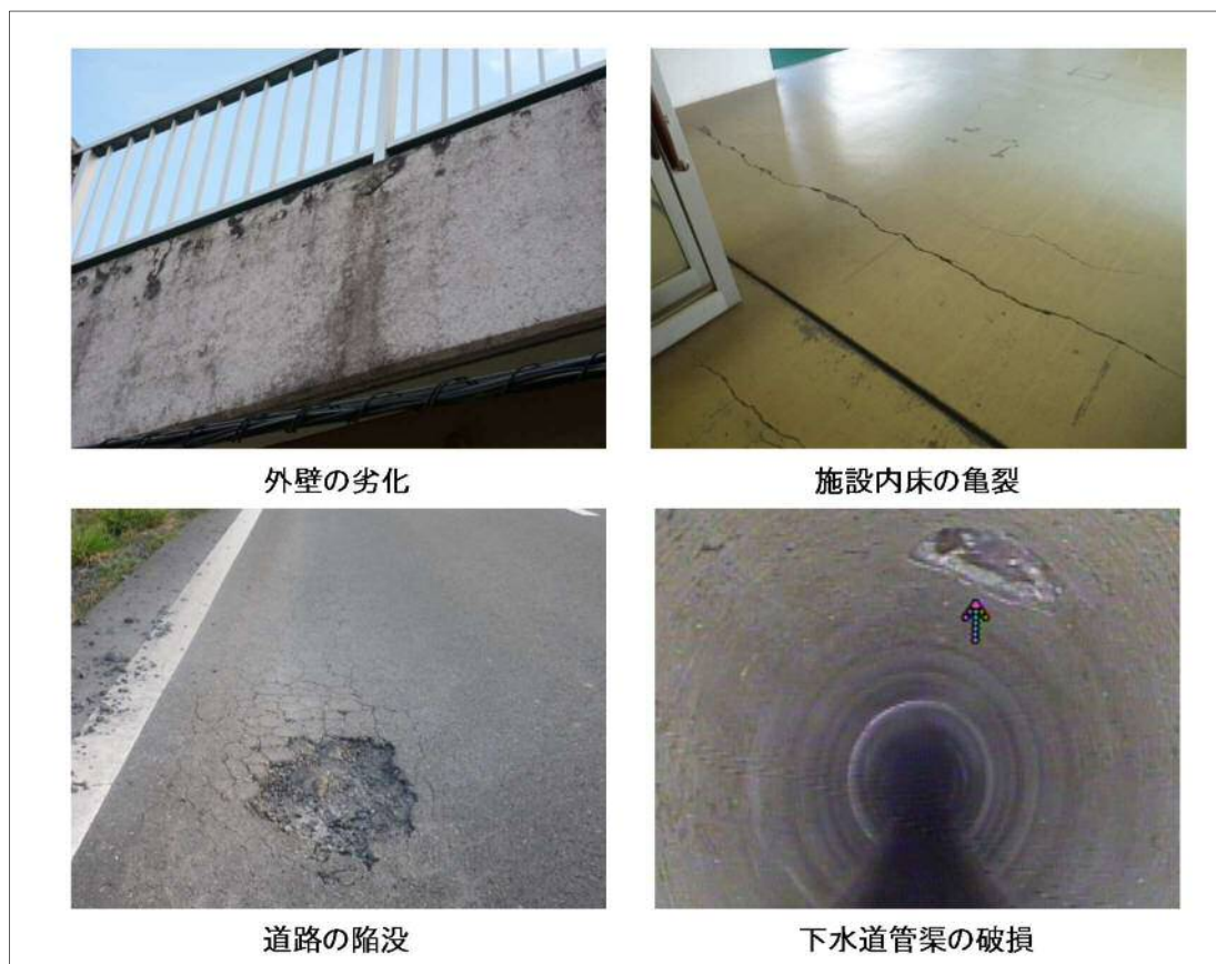
図 2-9 安全確保を要する現場の例
