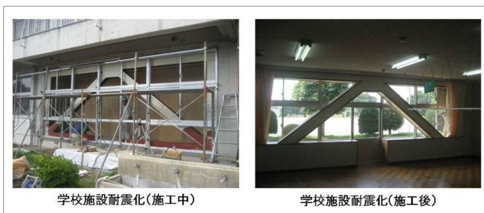
図 2-10 耐震性向上の施工（公共施設の例）
