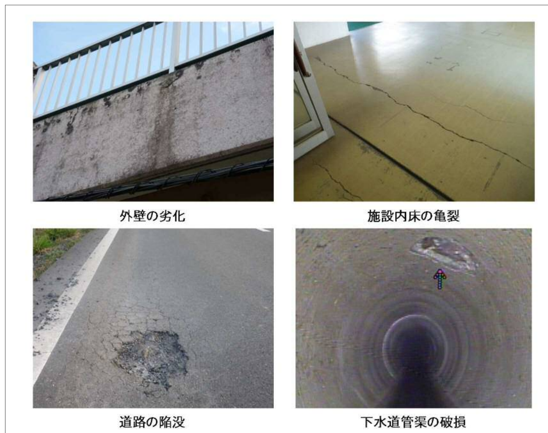
図 2-9 安全確保を要する現場の例
