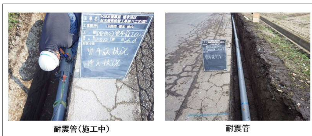
図 2-11 耐震性向上の施工（都市基盤施設の例）
