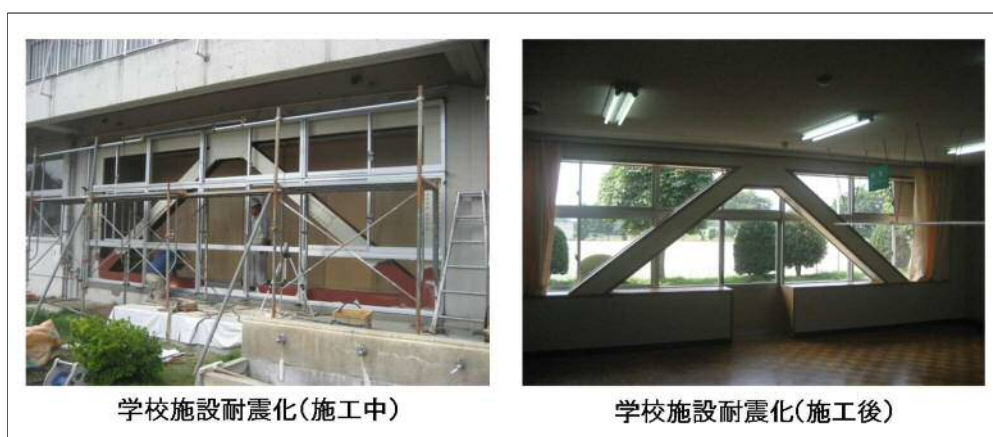
図 2-10 耐震性向上の施工（公共施設の例）
