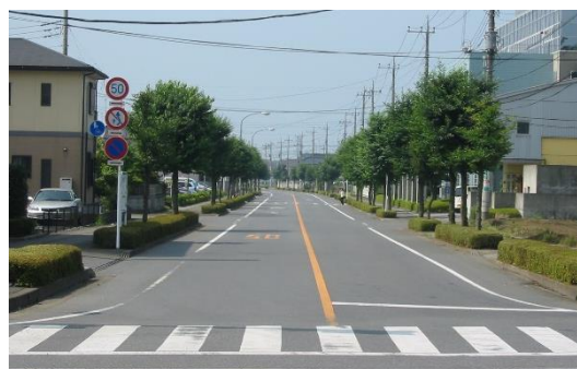
【都市計画道路小金井西通り (小金井駅周辺の整備済区間)】
