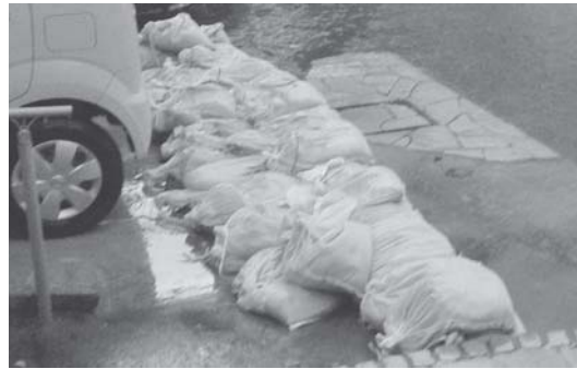
宅地内浸水を防止するため積まれた土のう
