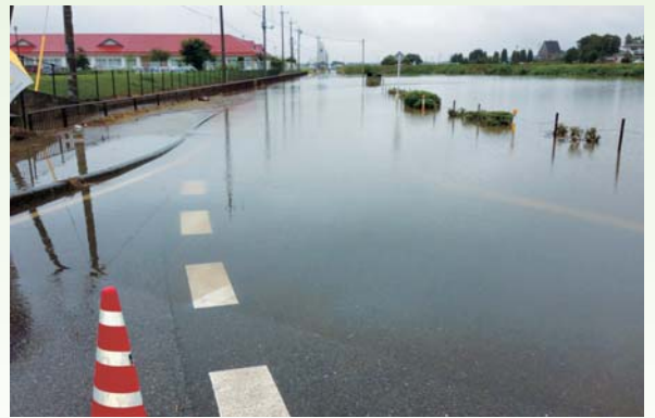
冠水した道路（きらら館駐車場東側）
