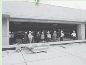
新庁舎建設工事現場
