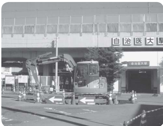
工事が始まった自治医大駅西口前
