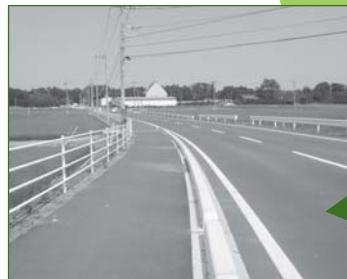
道路改修・新設により安全確保、利便性を高めた。
