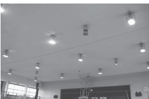
南河内中学校体育館の天井
