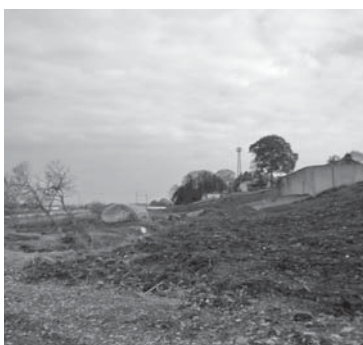
土地区画整理事業の工事現場
