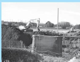
撤去がすすむ旧東田橋
