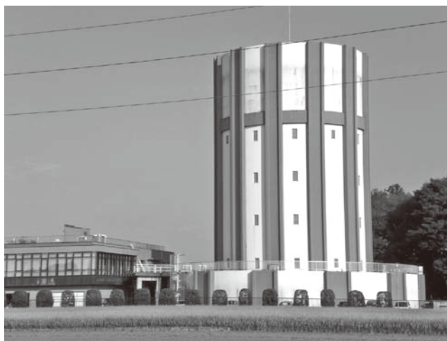
水道・下水道庁舎に隣接している配水場（南河内地区）
