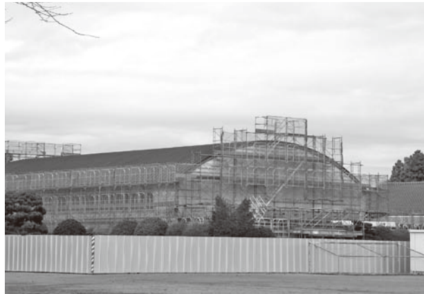
耐震化工事中の細谷小屋内運動場
