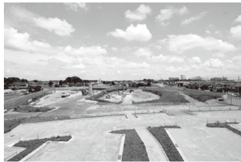
新庁舎建設工事現場
