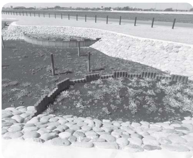
冬季には、かん水されないビオトープ(道の駅北側)
