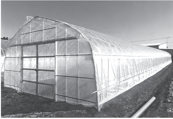
新しく建設されたビニールハウス
