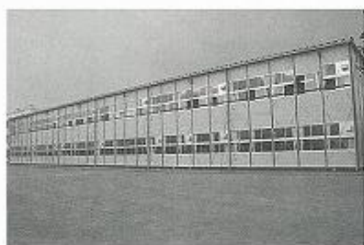
耐震補強工事のための石橋小仮設校舎
