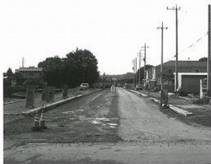
建設中の都市計画道路3-4-901号線
