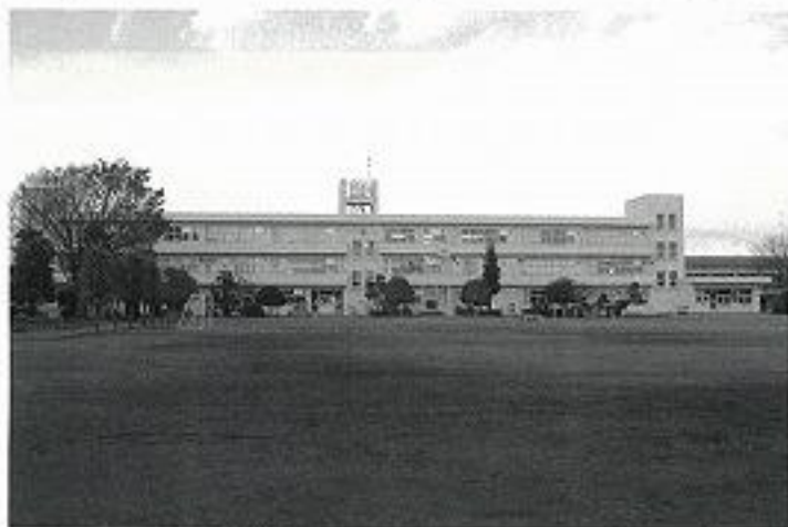
大規模改修予定の古山小学校
