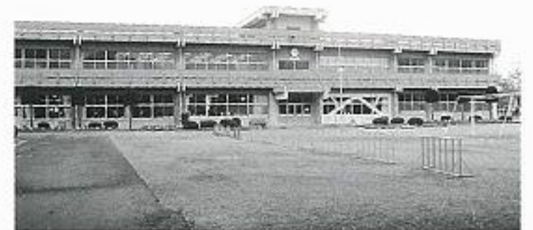
大規模改修する国分寺小学校校舎
