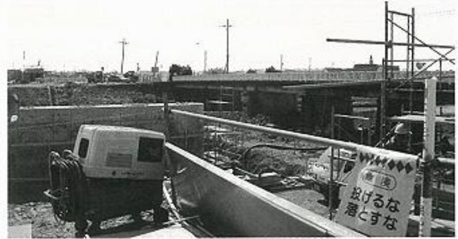
長田橋架けかえ工事のようす
