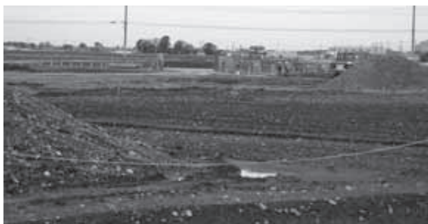
建設中の道の駅
