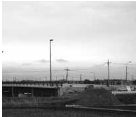
建設中の長田橋
