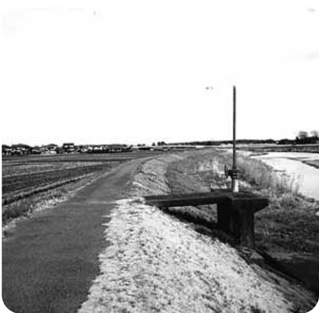
増水時には逆流対策で閉じられる樋門
