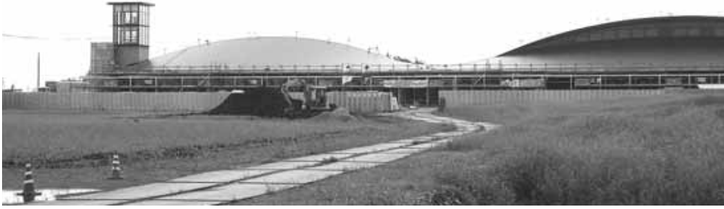
建設中の道の駅しもつけ(仮称) (7月15日撮影)
