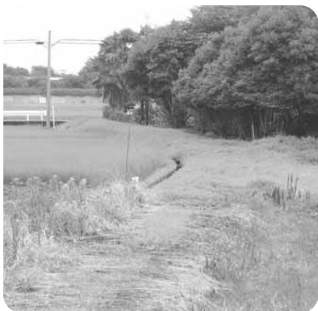
平成24年度から改良工事が予定されている農道
