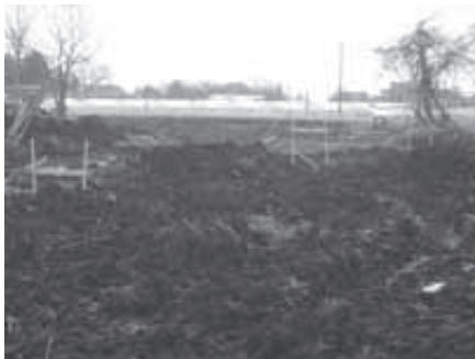
整備中の三味場ため池
