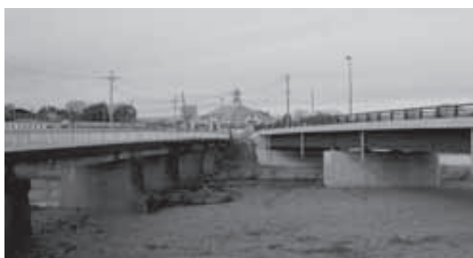
長田橋の旧橋(左)と新橋(右)
