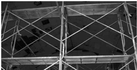
補修工事中の国分寺中学校体育館
