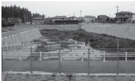
南河内庁舎南側に設置された第一工区の調整池
