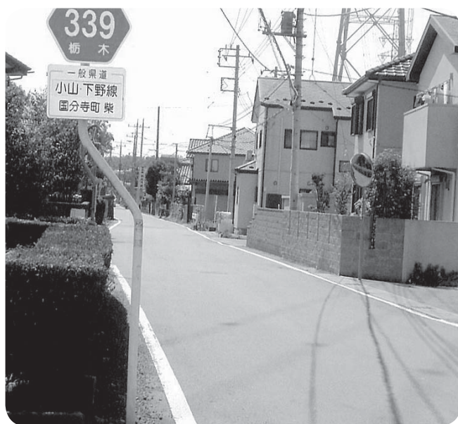
歩道が設置されていない県道小山・下野線(柴地内)
