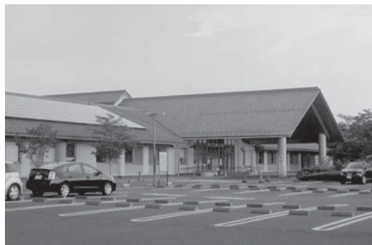
ゆうゆう館に非常用発電装置を整備する
