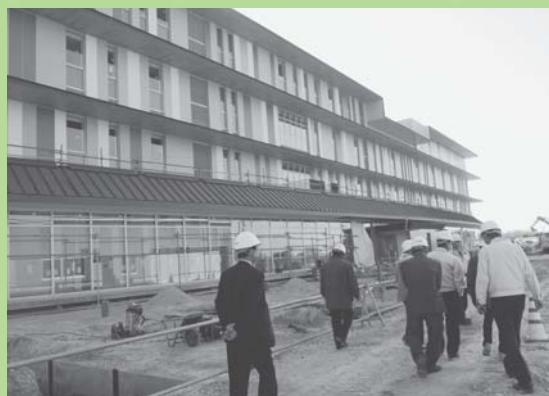
足場が外され、外観がみえるようになった新庁舎を調査しました。
