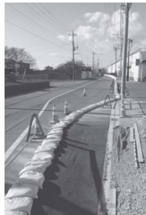
ヨークベニマル南側の工事箇所
