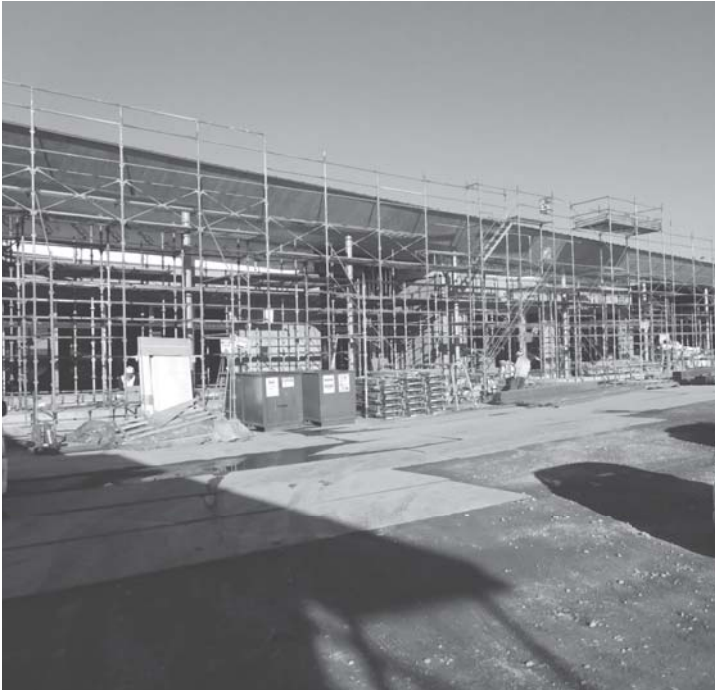
建設中の薬師寺コミュニティセンター施設
