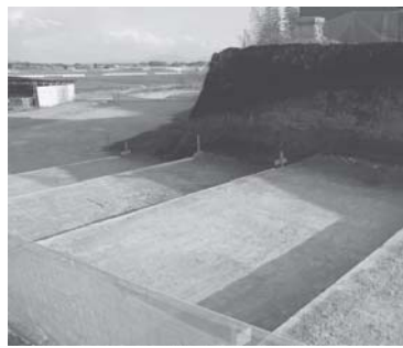
市道8168号線（仁良川）の擁壁整備現場
