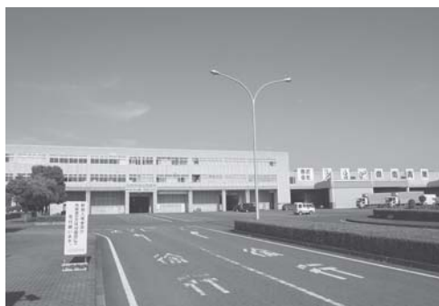
栃木県南公設地方卸売市場
