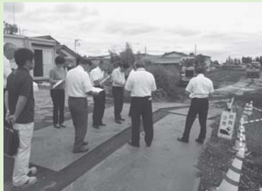
仁良川地区土地区画整理事業現場
