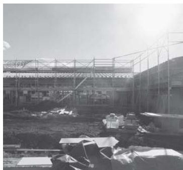
建設中の都市農村交流施設
