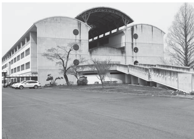
東から見た石橋中学校。中央にトラス構造の木造屋根が見える。
