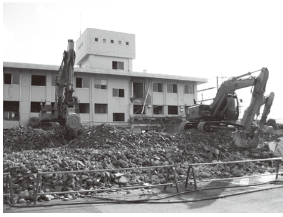
旧石橋総合病院の解体工事現場
