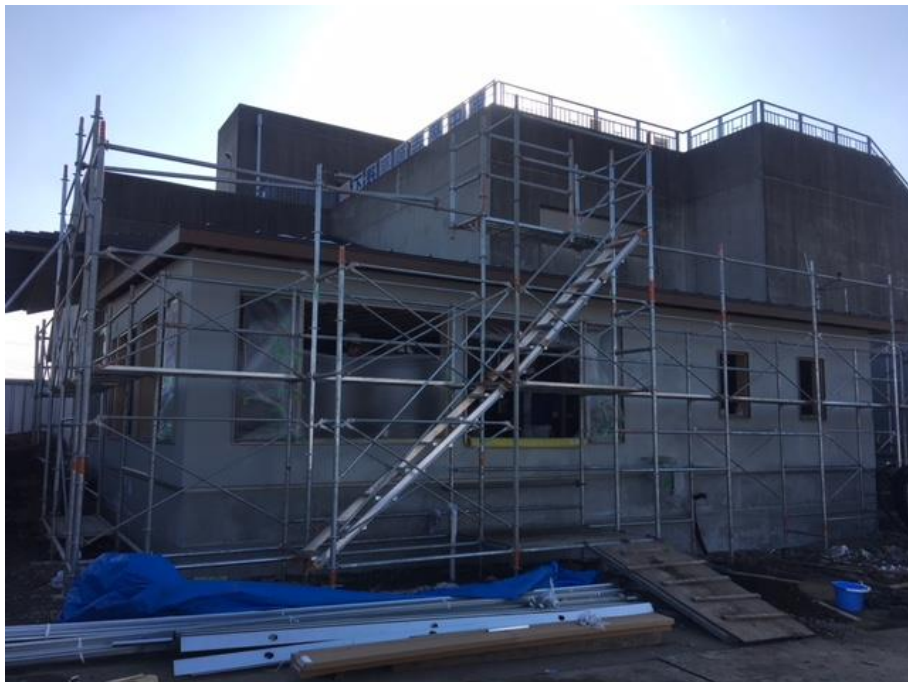
外観（北側から）
