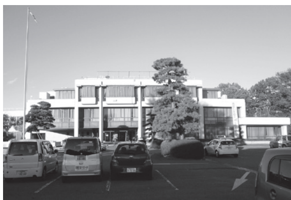
平成31年度に解体予定の旧国分寺庁舎
