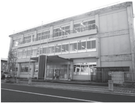
解体予定の旧石橋庁舎
