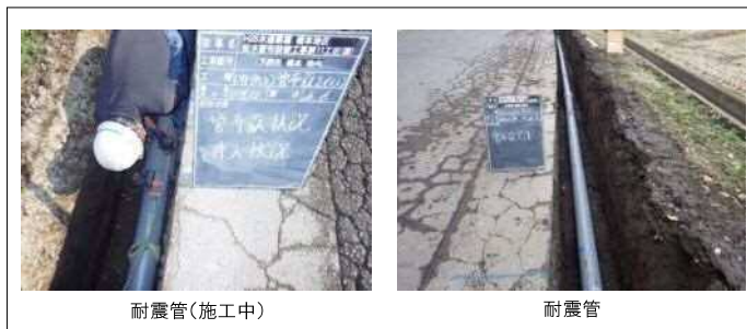
【耐震性向上の施工（都市基盤施設の例）】
