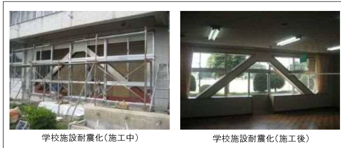
【耐震性向上の施工（公共施設の例）】
