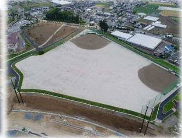
多目的グラウンド(完成)
