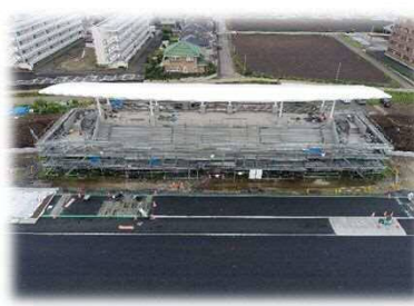
陸上競技場管理棟(10月末完成予定)
