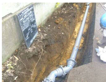
ダクティル鑄鉄管（GX 型）布設工事
