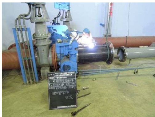
設備配管更新
