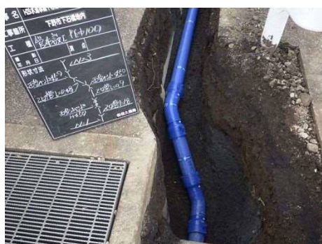
配水用ポリエチレン管布設工事
