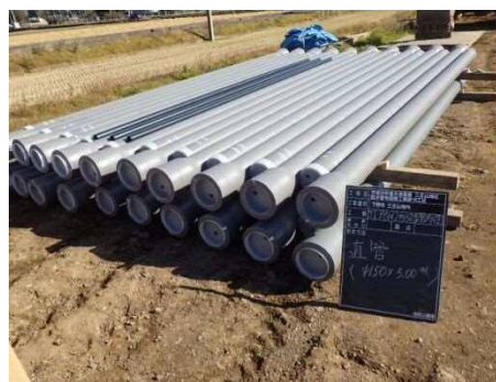
ダクティル鑄鉄管（GX 型）
