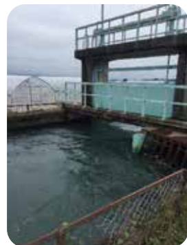
現在の取水口（真岡市）
