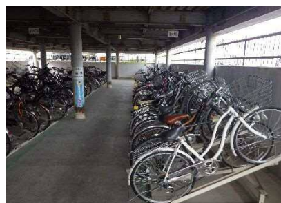
小金井駅東自転車駐車場
