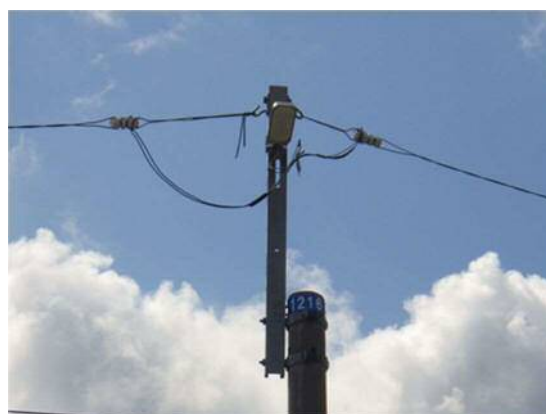
LED化された防犯灯
