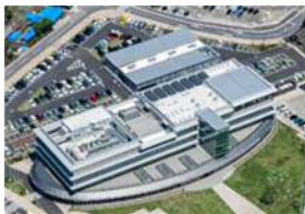
屋上部に太陽光パネルが設置された市庁舎
