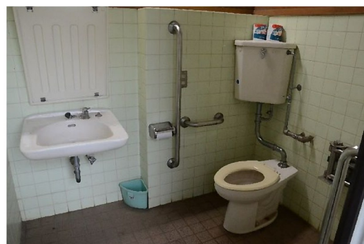
花広場のトイレ（障がい者用）
