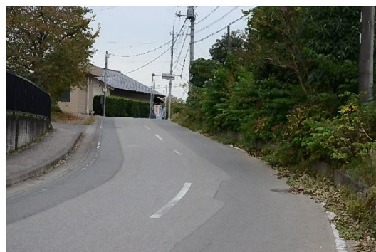
市道2-22号線の歩道・舗装
