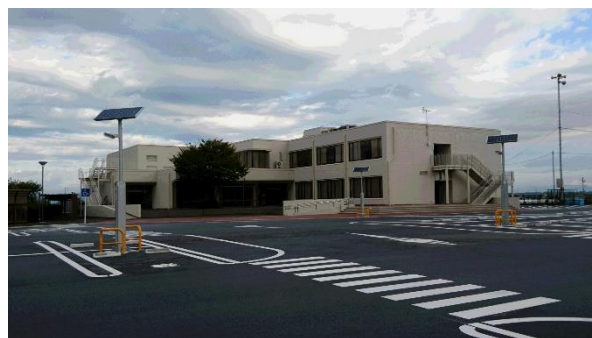
国分寺公民館改修工事
